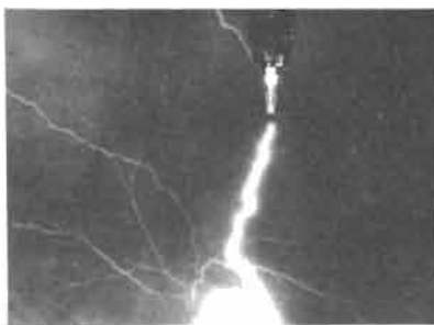
Fig. 1 Il parafulmine dello Empire State Building di New York colpito da una scarica atmosferica. In media, il culmine del grattacielo viene colpito 48 volte all'anno; il record è stato quello di 8 fulmini durante uno stesso temporale. (foto dall'archivio del Lightning Protection Institute).
